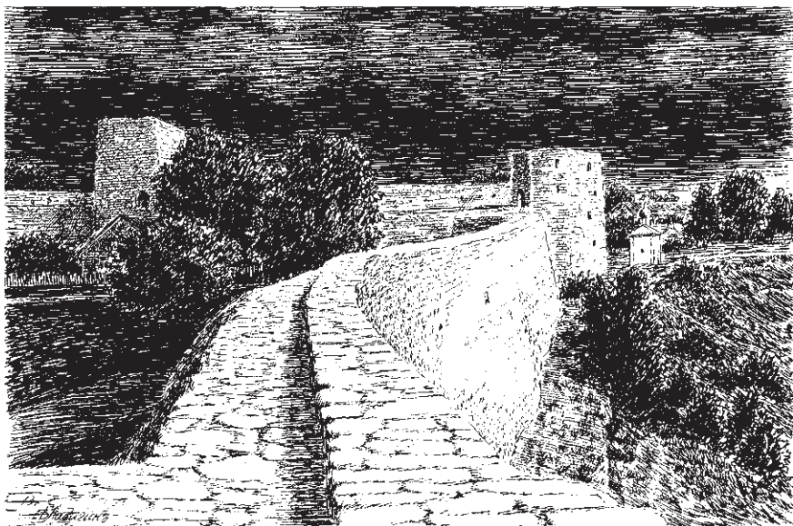
Башня Вышка и Талавская. Спереди Северное прясло стены. Вид от Башни Луковка
