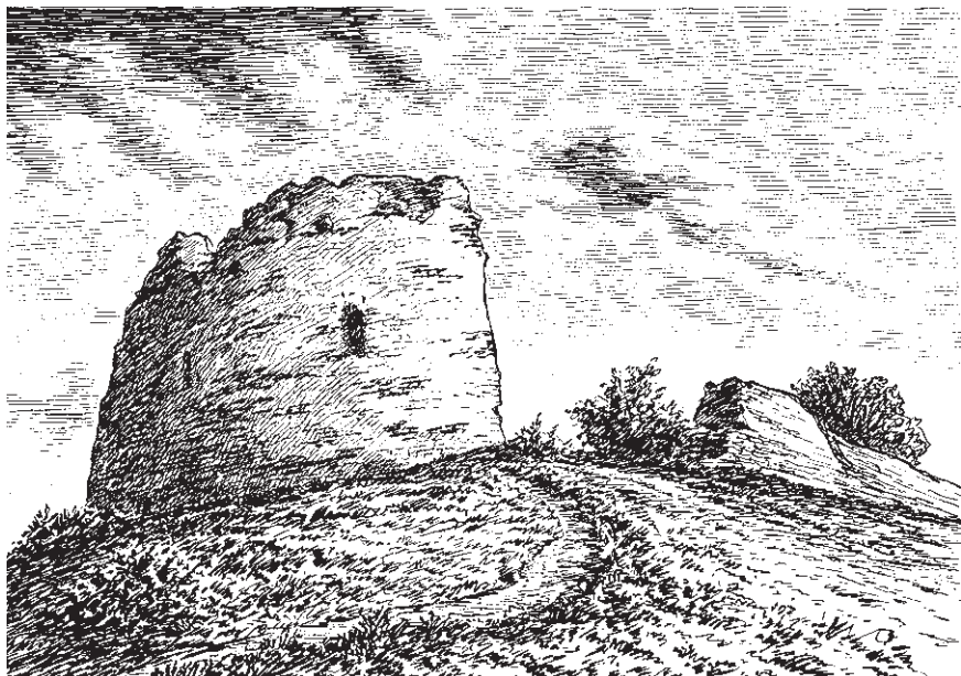
Варлаамовская башня до реставрации
